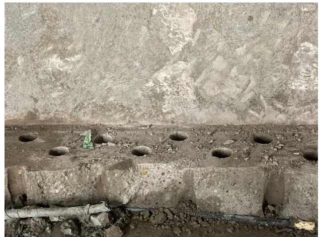
② コア穴、穿孔状況
