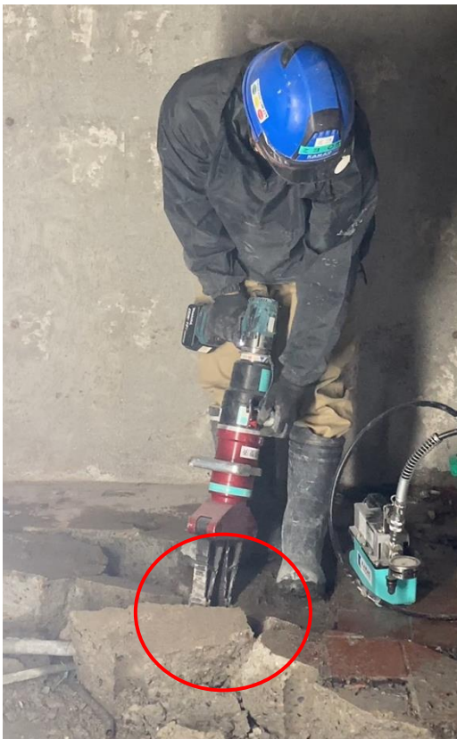
④ 割裂した部分に、SP コンビツールを差し込み、さらに亀裂をひろげ縁切りをさせていきます。
